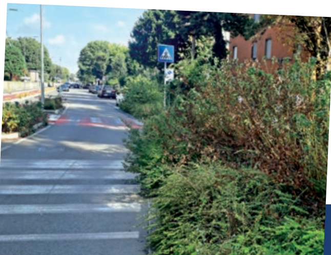
Visibilità ridotta nei pressi dell'attraversamento pedonale di via De Gasperi a causa dell'aiuola
